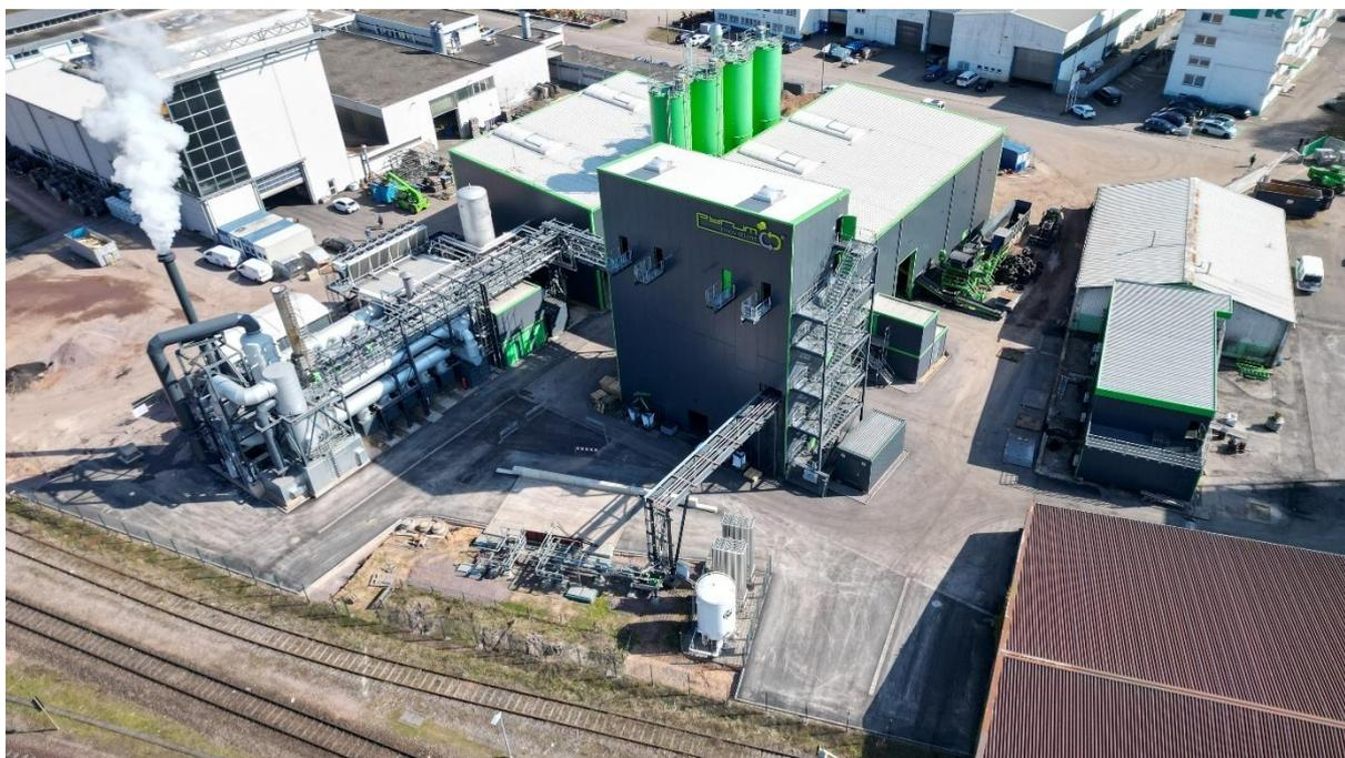
Im Februar 2024 wurde der erste der beiden neuen Reaktoren während seiner zweiten Probefahrt erstmals auf 75 % der vorgesehenen Nennleistung hochgefahren. Der Materialdurchsatz wurde dabei innerhalb einer Woche sukzessive auf den vorgesehenen Wert erhöht – deutlich früher als geplant, da ursprünglich ein dreimonatiger Hochlaufzeitraum vorgesehen war.
